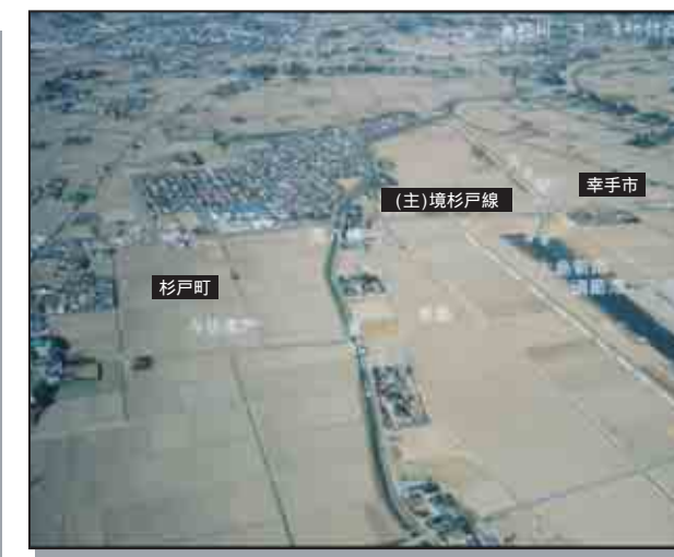
倉松川8km 付近
