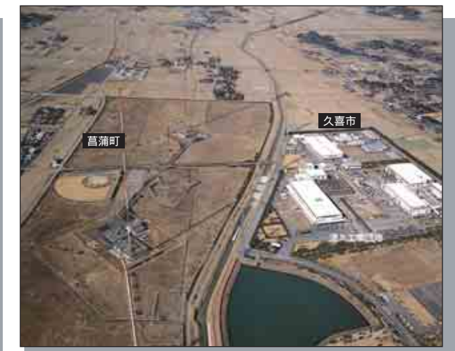
備前堀川8.0km 付近
