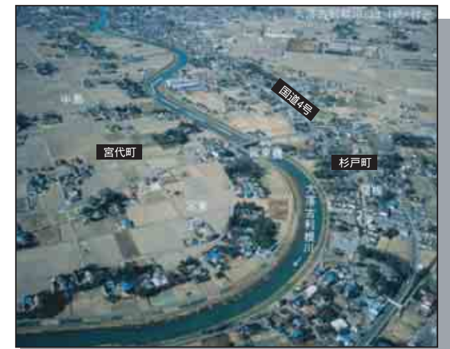
大落古利根川18km 付近
