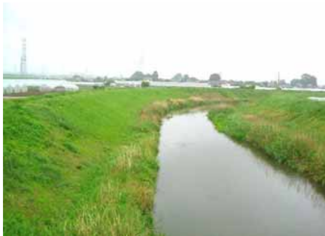
備前渠川（本庄市大字滝瀬地内／平成10年度施工）
