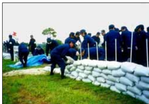
土嚢積み（水防演習）
