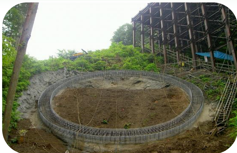
①鉄筋配筋
