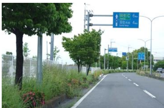
植樹帯に雑草が繁茂 (県道鴻巣羽生線／行田市)
