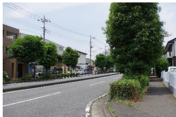
下枝が伸びて支道から進入する際の見通しを阻害 (県道練馬所沢線/所沢市)
