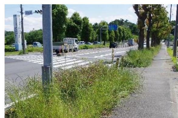
横断歩道に近接する高木が横断者を隠す (国道462号/本庄市)
