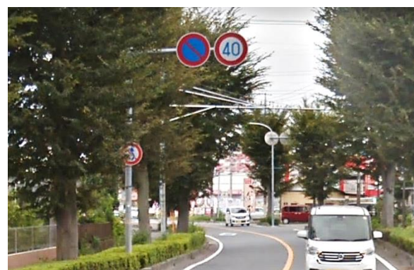
ケヤキの幹がカーブの視距を阻害 (県道熊谷館林線/熊谷市)
