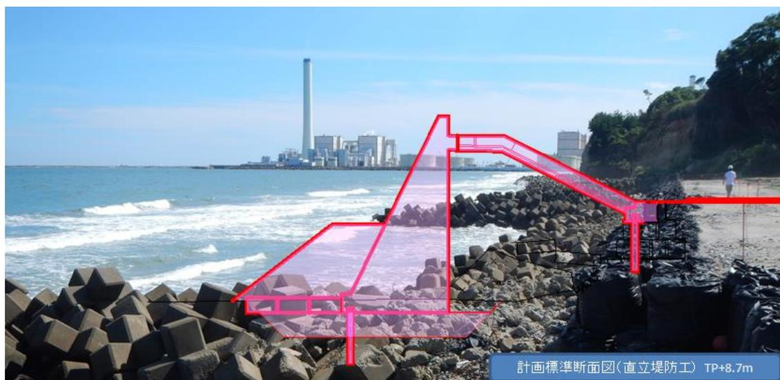
現在の状況は、仮設消波ブロックの設置と仮設鋼矢板打設等で、本体堤防工設置の準備段階であり、現場が海の中での作業であるため、気象条件等に左右され困難を来しています。
