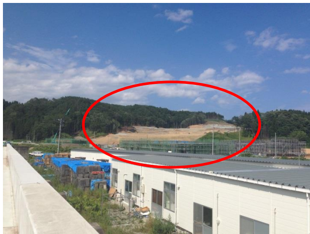
防災集団移転促進事業に伴う造成工事の様子
