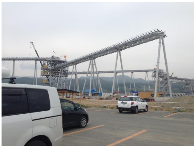
区画整理事業における嵩上げのための 土を山から運ぶためのベルトコンベア
