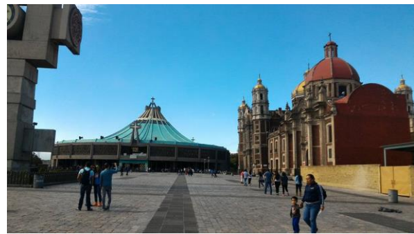
地盤沈下の例。右側の教会が前の方に傾いている
