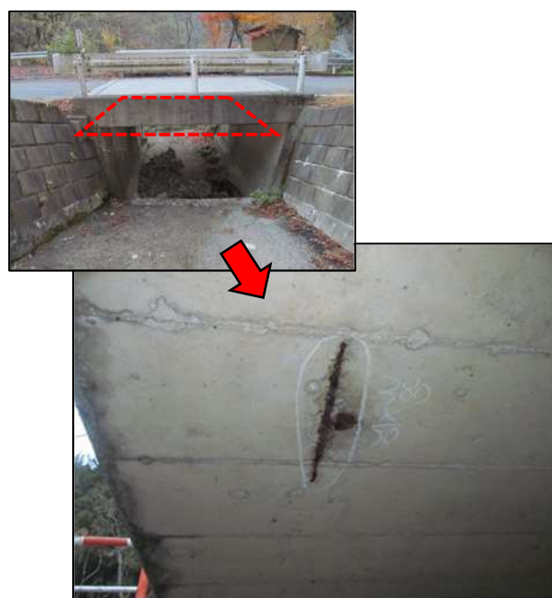
点検の実施による劣化状況の把握
