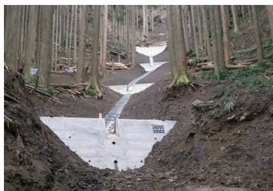
治山施設の設置
