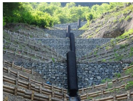
治山施設の設置
