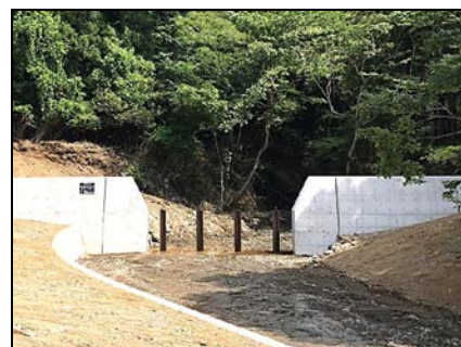
治山施設の設置
