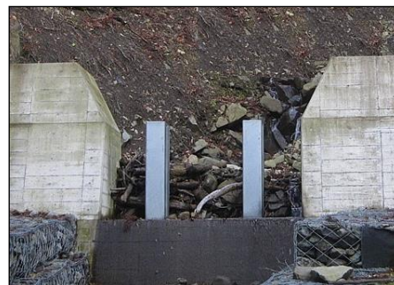
治山施設の設置
