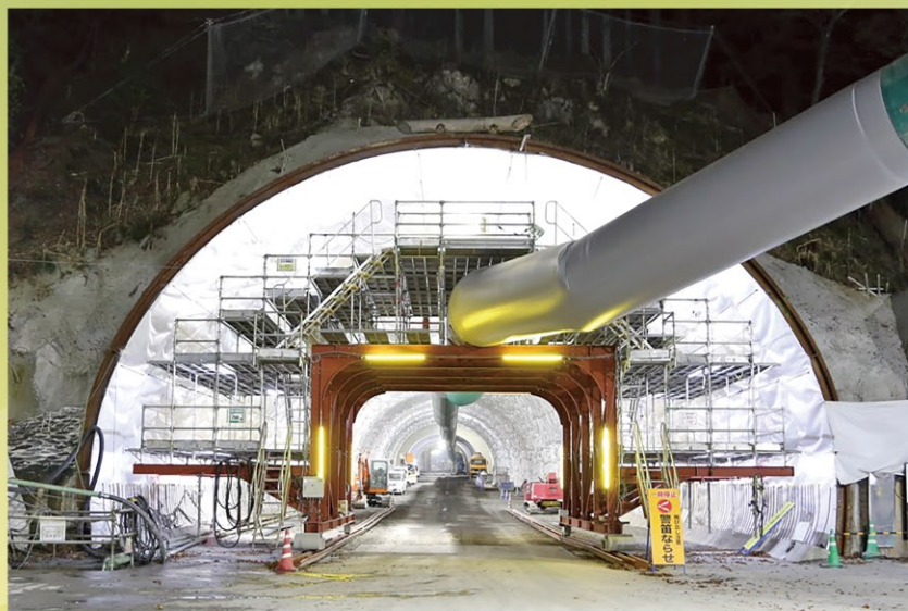
国道140号／大滝トンネル(工事中)
