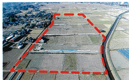
ほ場の整備中の状況
