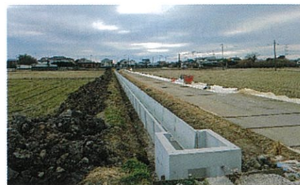
用排水路の整備中の状況
