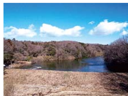
対策が必要なため池
