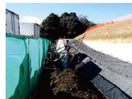
防災対策(耐震化)を実施中のため池
