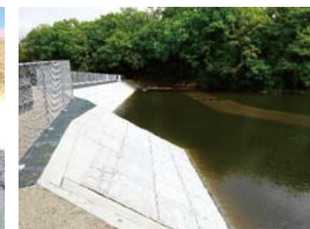
防災対策(耐震化)が完了したため池
