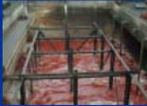
中間処理水(調整槽)
