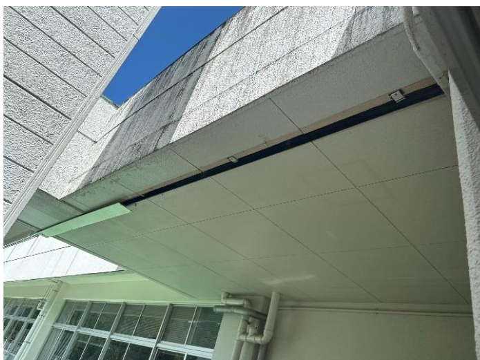
【Exp.J.c(エキスパンションジョイントカバー)の落下】
