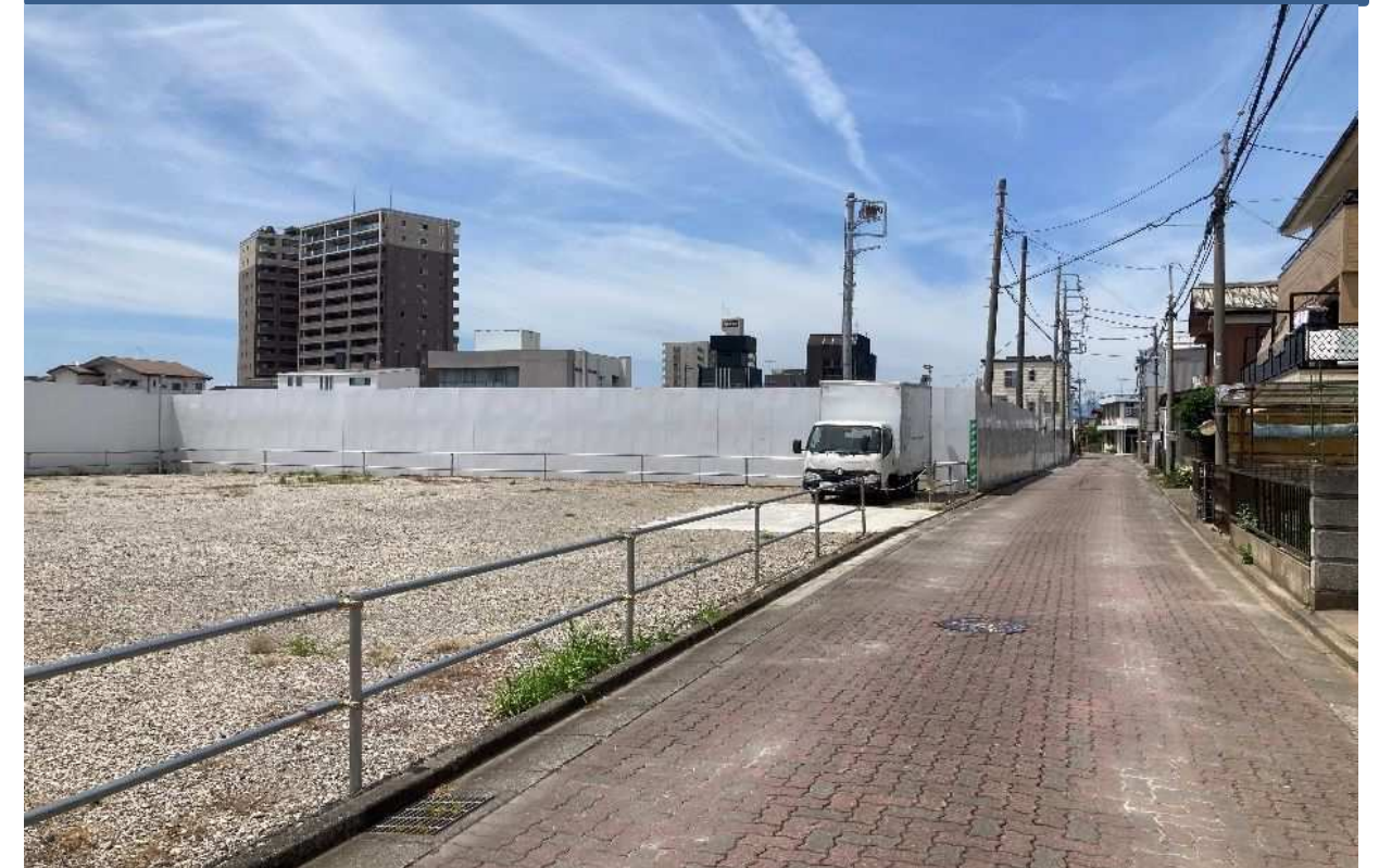
④ 計画地東側敷地境界(計画地東側から撮影)
