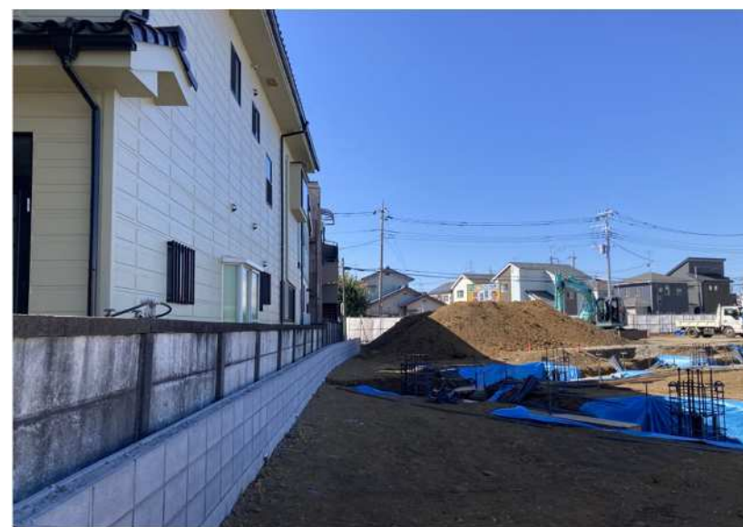
④店舗南東側敷地境界(防音壁設置側)
