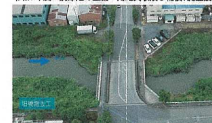
弁天橋(架換え前:18.0m⇨架換え後:36.2m)
