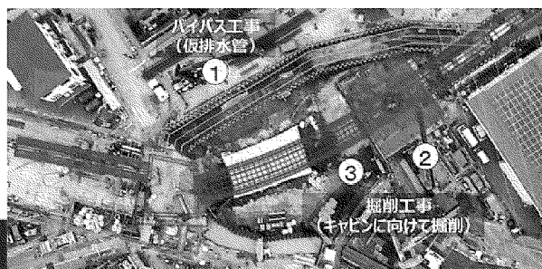
八潮市道路陥没事故 バイパス工事・掘削工事(土木的措置)の概要 →
