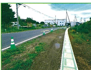
側溝設置の工事が進む用地買収した部分
