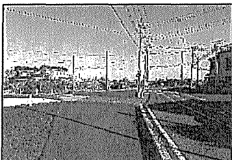
なだらかに整備をした県道との接合部
