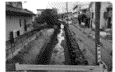
⑥上新井の崩落したガードレールの撤廃 復旧工事
