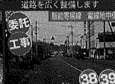
電線の地中化を整備します
