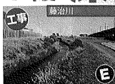
護岸の工事を行ないます
