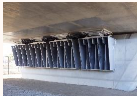
橋りょうの耐震化 (入間川高架橋/入間市)
