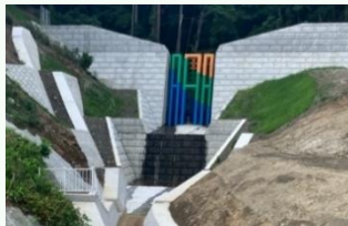
砂防関係施設整備 (滝山・萬開沢/ときがわ町)
