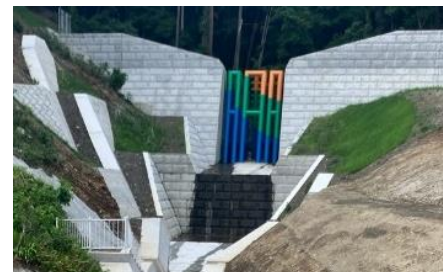
砂防関係施設
