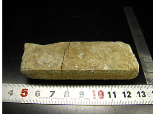
図 7.16.5b スレート板表面写真
