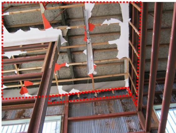
図 7.10a 鉄骨建築物の内壁
