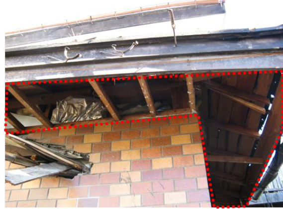
図 7.8b 一般住宅の軒天板（撤去後）
