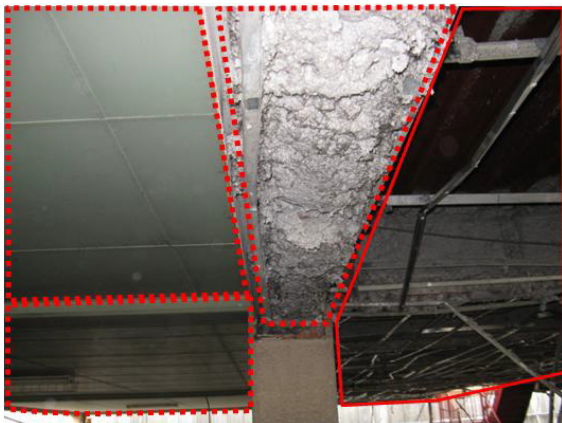
図 7.5a 駐車場の天井
