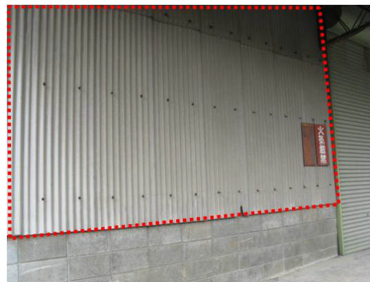
図 7.1b 表面が劣化していない軒下の壁 建築物の写真中の赤点線で囲った部分が、
