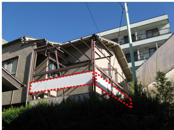
図 7.7a ベランダの目隠し板
