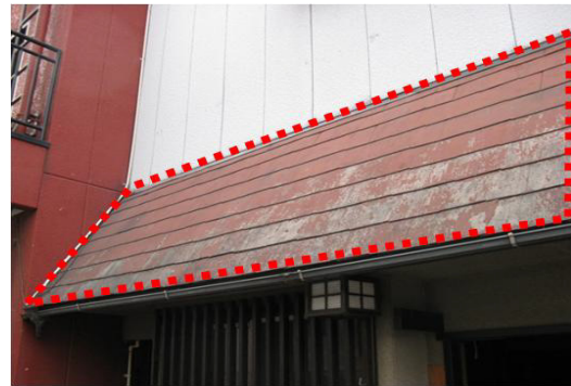
図 7.2b コロニアル施工事例
