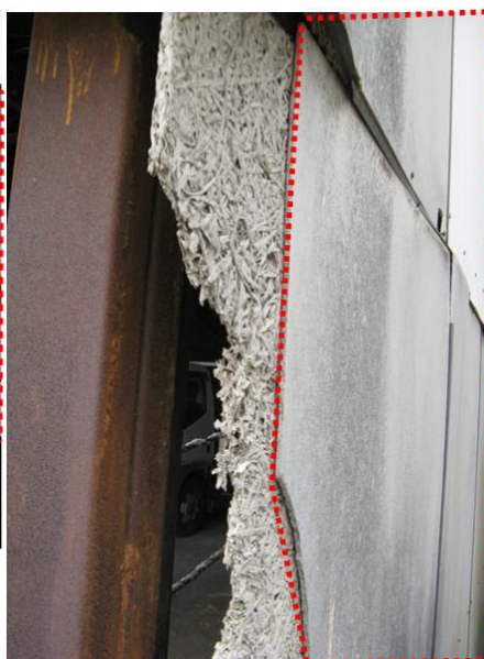
図 7.3b 事務所の外壁材
