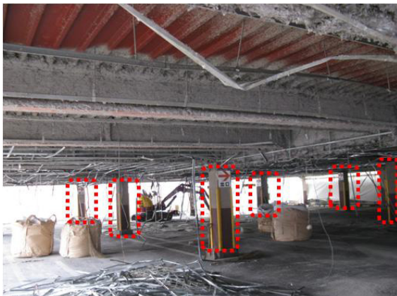
図 7.4a 耐火被覆板は駐車場の柱で使用
