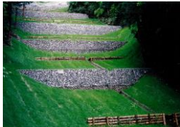
治山施設の整備
