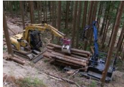
伐採・搬出作業
