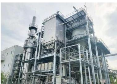
下水をきれいにする過程で発生した汚泥(ごみ)を焼却し、灰などにして再利用しています。
