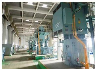
下水が水循環センターまで流れよう、途中でくみ上げる施設を中継ポンプ場といいます。大きいものでは、直径約1.7mのポンプで下水をくみ上げています。
