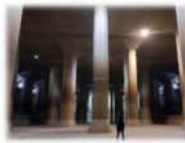
春日部市 首都圏外郭放水路
