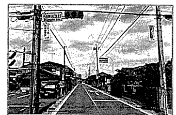
舗装打ち換え前の県道春日部久喜線
