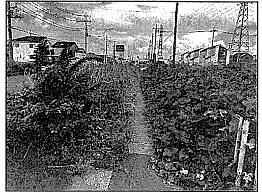
草が繁茂して通行困難な県道歩道
