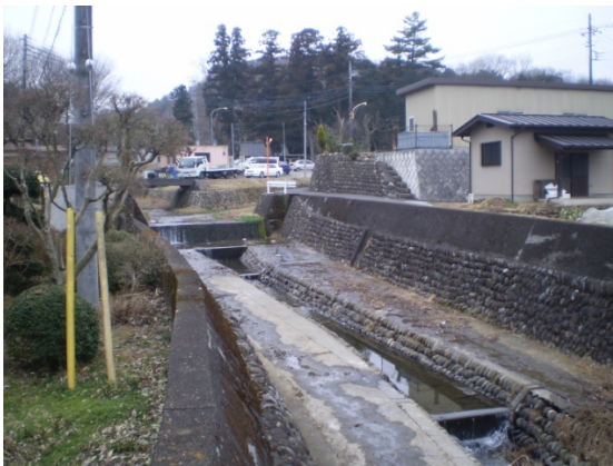
唐沢（飯能市阿須、昭和 35 年頃） 八高線上流の玉石三面張と落差工
