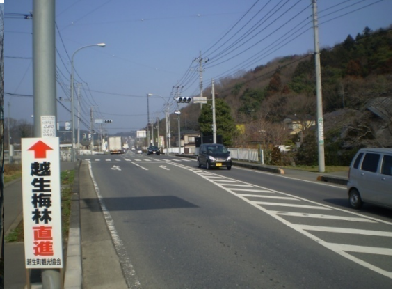
飯能寄居線バイパス 越生町、平成 6 年
