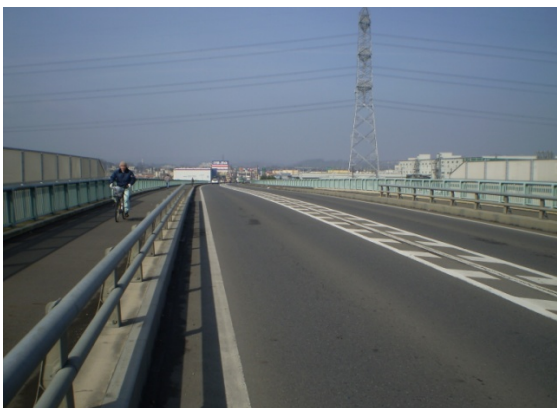
川越坂戸毛呂山線バイパス 坂戸市関越道付近、平成 13 年 坂戸入西大橋
