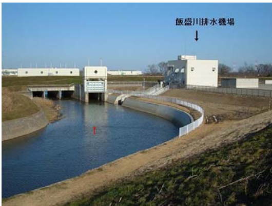
飯盛川排水機場（坂戸市小沼、平成 17 年） 洪水をポンプで越辺川に強制排水
