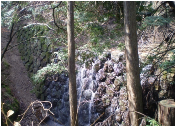
龍ヶ谷川（越生町竜ヶ谷、昭和26年） 戦後間もない頃の石積の堰堤
