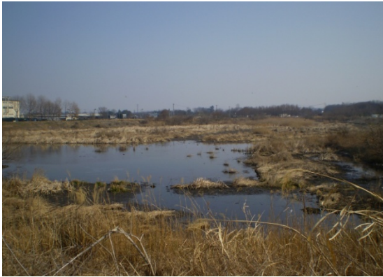
大森調節池（不老川、入間市宮寺） 洪水を一時的に調節池に貯留
