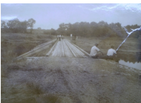
整備前（木の冠水橋）
