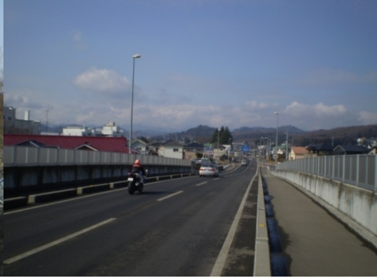
国道 299 号飯能狭山バイパス 飯能市中山陸橋付近、平成 18 年
