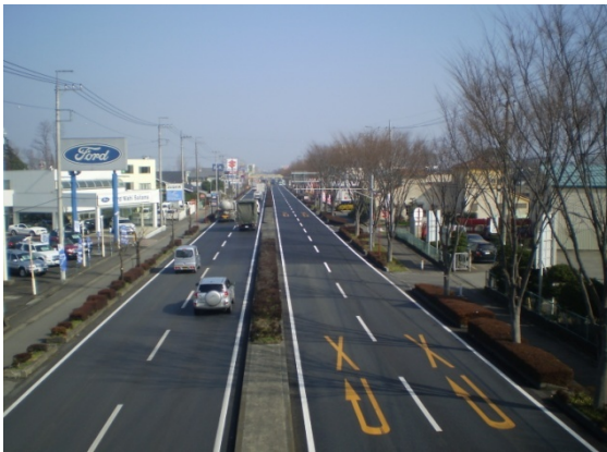
国道 407 号坂戸鶴ヶ島バイパス 鶴ヶ島市、昭和 61 年 4 車線化
