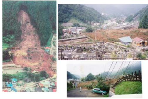
平成 11 年 8 月吾野駅付近の災害 駅ホームが土砂に埋まる
