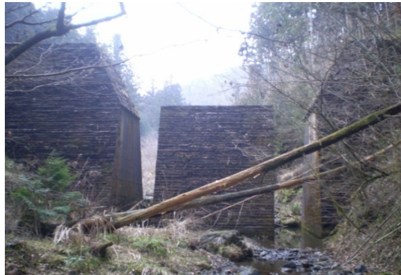
蕨入（飯能市赤沢、平成8年） スリットを入れ環境にも配慮した堰堤
