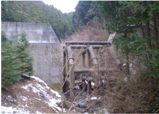
高畑川（飯能市高山、平成 11 年） 鋼製格子を使った堰堤
