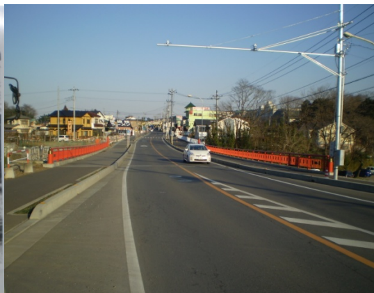
整備後（平成 18 年、橋長 43.7m、幅 15.5m）
