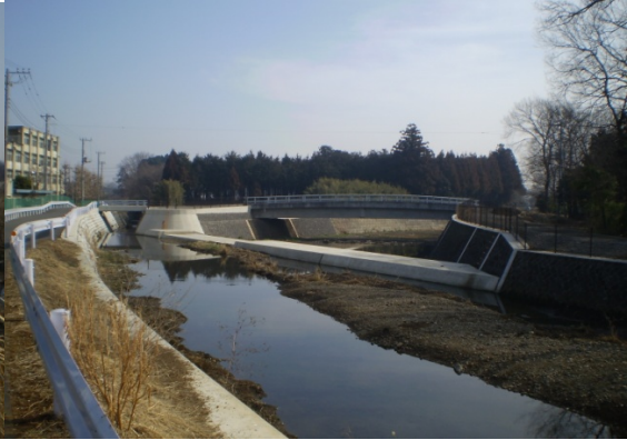
葛川放水路（毛呂山町～坂戸市、平成 21 年） 葛川の洪水を高麗川に分流、写真は越流堤
