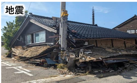
令和6年能登半島地震による被害(埼玉県撮影)
