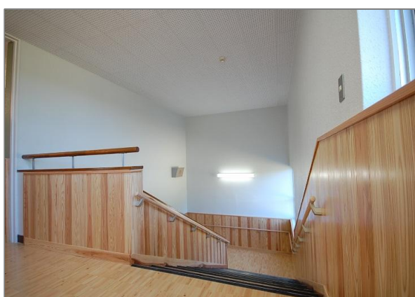
写真⑥ 校舎内観（階段） 腰板はときがわ町産スギ材、床は国産ヒノキ集成材を使用。
