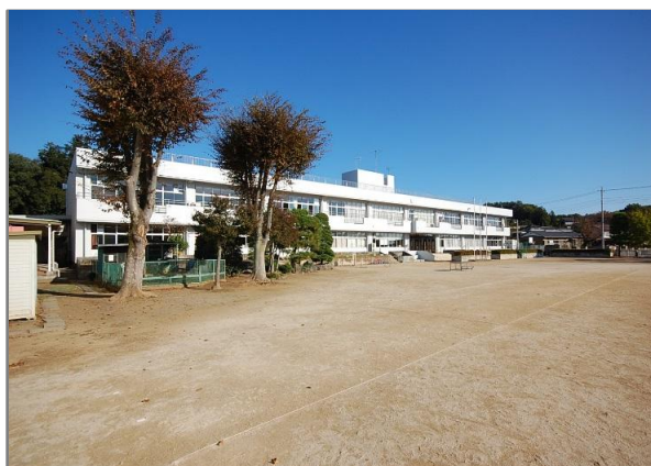
写真② 改造後の校舎外観（南側より撮影） クラック補修後、外壁の塗装については、ゆず肌状ローラー仕上げとした。
