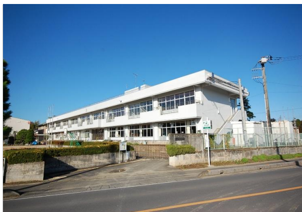
写真① 改造後の校舎外観（東側より撮影） クラックはUカットシール材充てん工法により補修。
