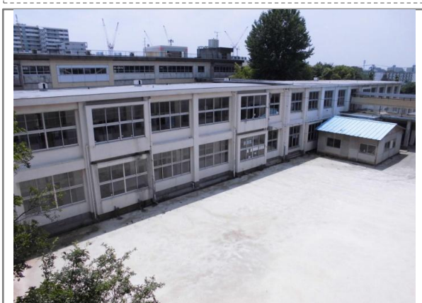
写真⑥ 旧校舎（外観） 昭和38年3月に竣工し、平成26年度に解体。旧 校舎中央棟を北側より撮影。
