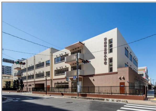
写真② 新校舎外観（東側） 改築工事により平成25年12月に竣工。 校舎北棟及び東棟を北東側より撮影。
