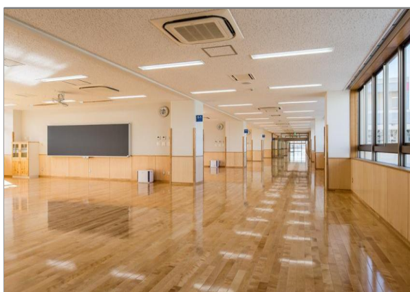
写真④ 新校舎内観（普通教室） オープンスペースとした普通教室の床・腰壁等に 木材を使用。また、ロッカー等の家具に埼玉県産ヒ ノキ燻煙乾燥材を使用。
