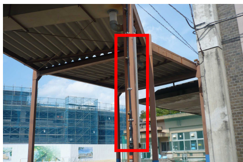
3 渡り廊下の柱に配管を固定
