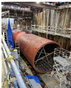
破損した下水道管の代わりに敷設した新しい下水道管（鋼製セグメント）
