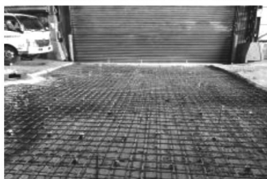
土間コンクリート・アスファルト舗装
