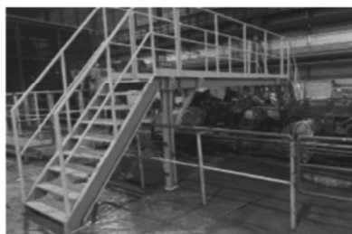
安全化対策工事(設計・製作・据付)
