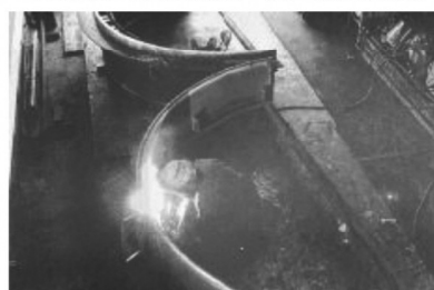
製缶加工・鉄部補修工事
