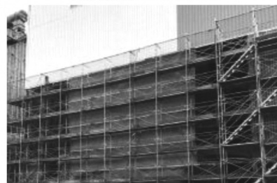
建屋屋根・外壁工事
