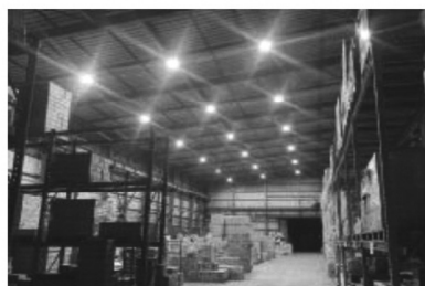
LED化工事(蛍光灯～大型灯具対応)
