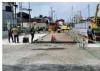
道路復旧工事状況（3/17撮影）
