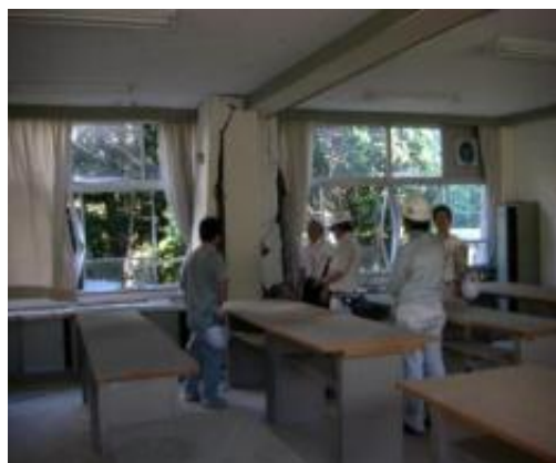
災害査定の様子（現地）
