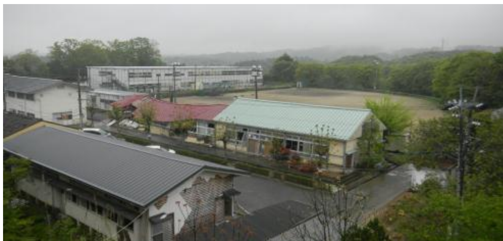
被災を受けた学校（奥の建物は仮設校舎）
