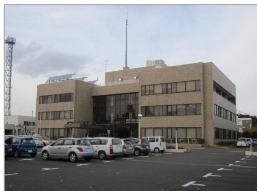
<仙台土木事務所>
