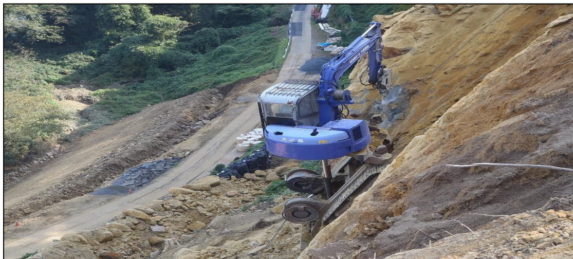
(高所岩盤掘削機による作業)
