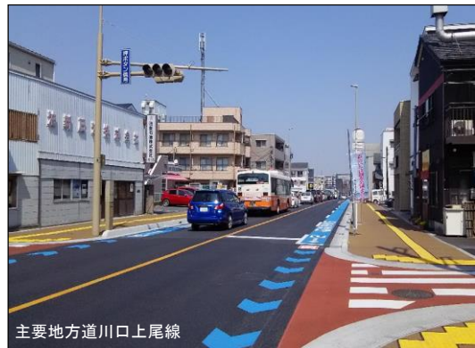
無電柱化完了後状況
