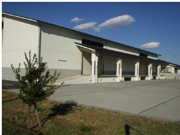
防災倉庫（中央防災基地）
