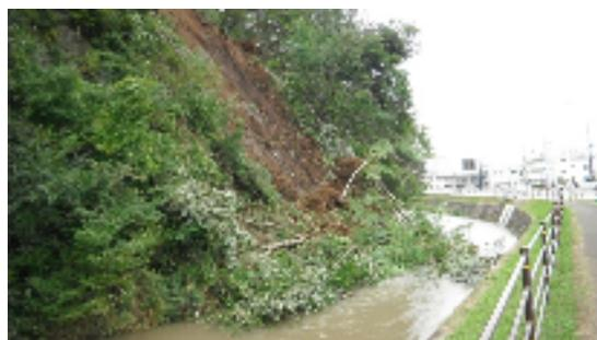
降雨強風により河川部法面の崩落
