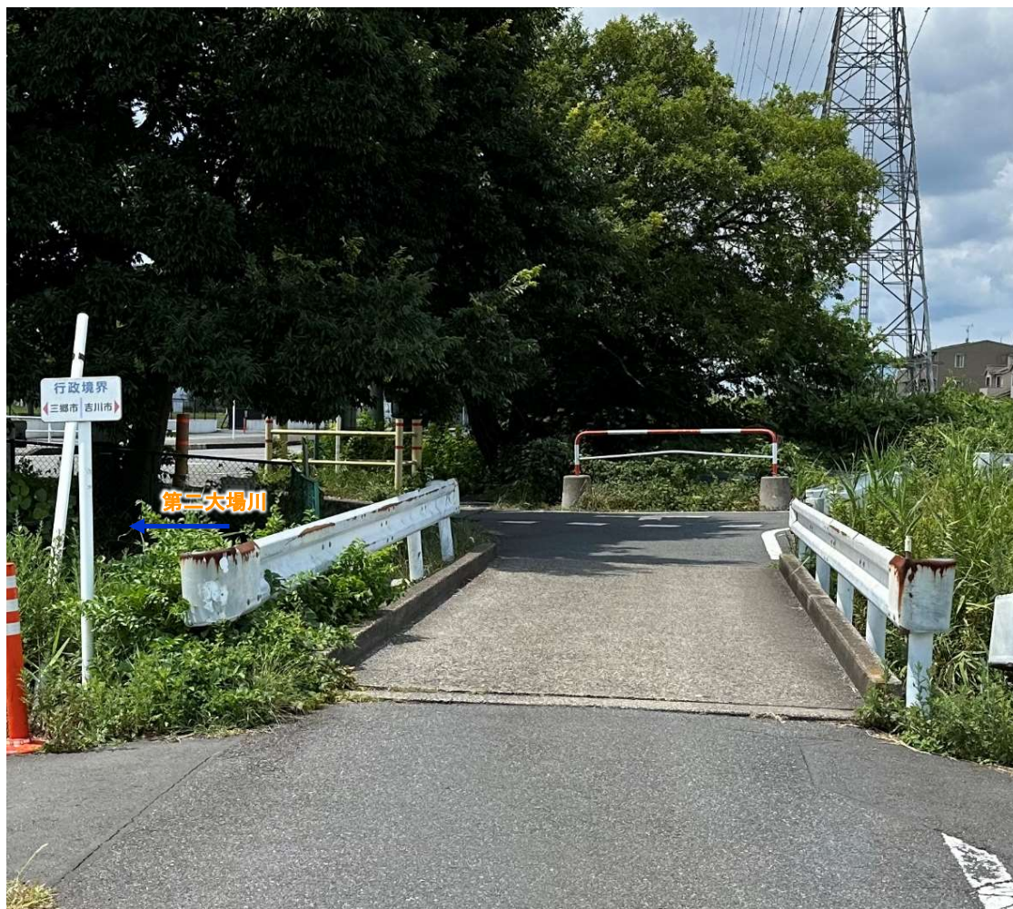
撤去する橋(無名橋)の現在の様子
