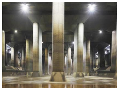
首都圏外郭放水路
