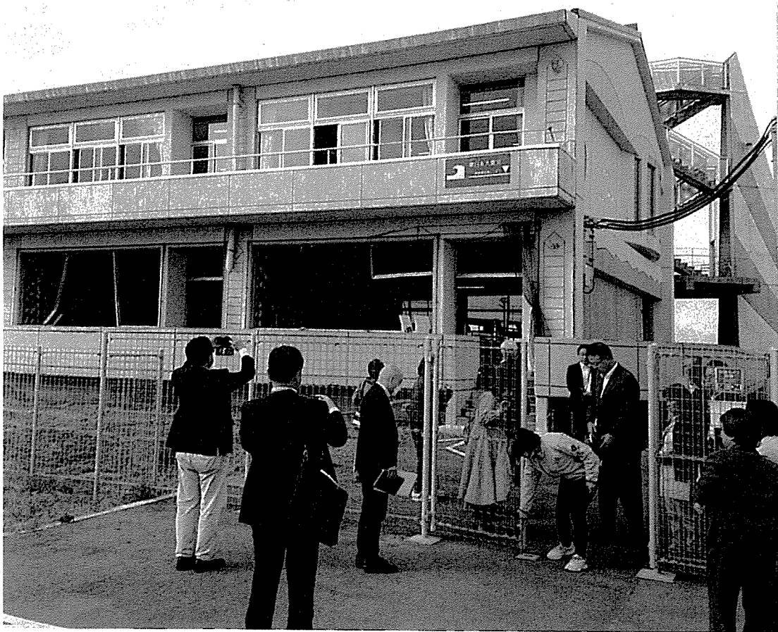
小学校外観 ⑥ 青い表示が【津波】の高さ
